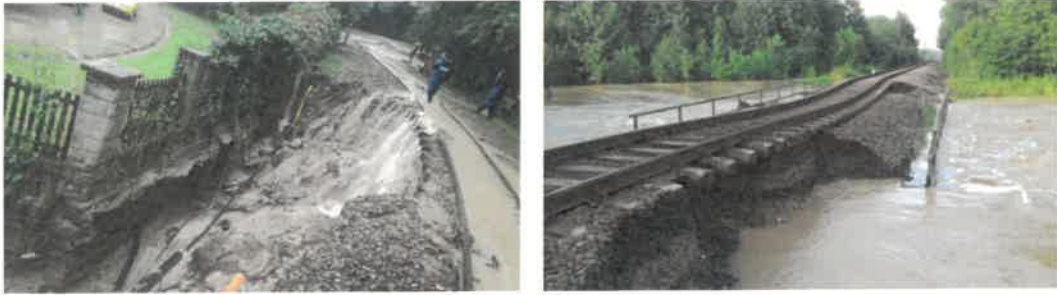
Villámárvíz okozta károk Szilvásváradon 2018-ban (balra) és a 41-es vasútvonalon Belegnél 2020-ban (jobbra) 1
