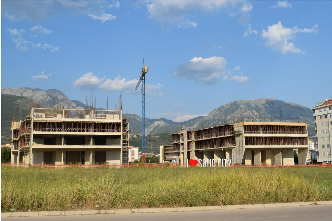
9. kép: A setback area területére tervezett Soho City hotel ikerépületeinek épülő váza
