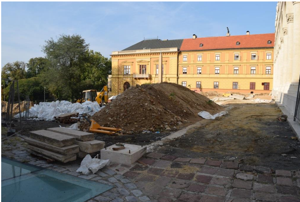
7/a. kép: A Székesegyház előtti téren folyik a munka: a vízvezetés megoldása és az ókeresztény sírkamrák újraszigetelése sürgős feladat, a legutóbbi felújítások ilyen irányú tevékenysége nem hozott ugyanis kellő eredményt.
