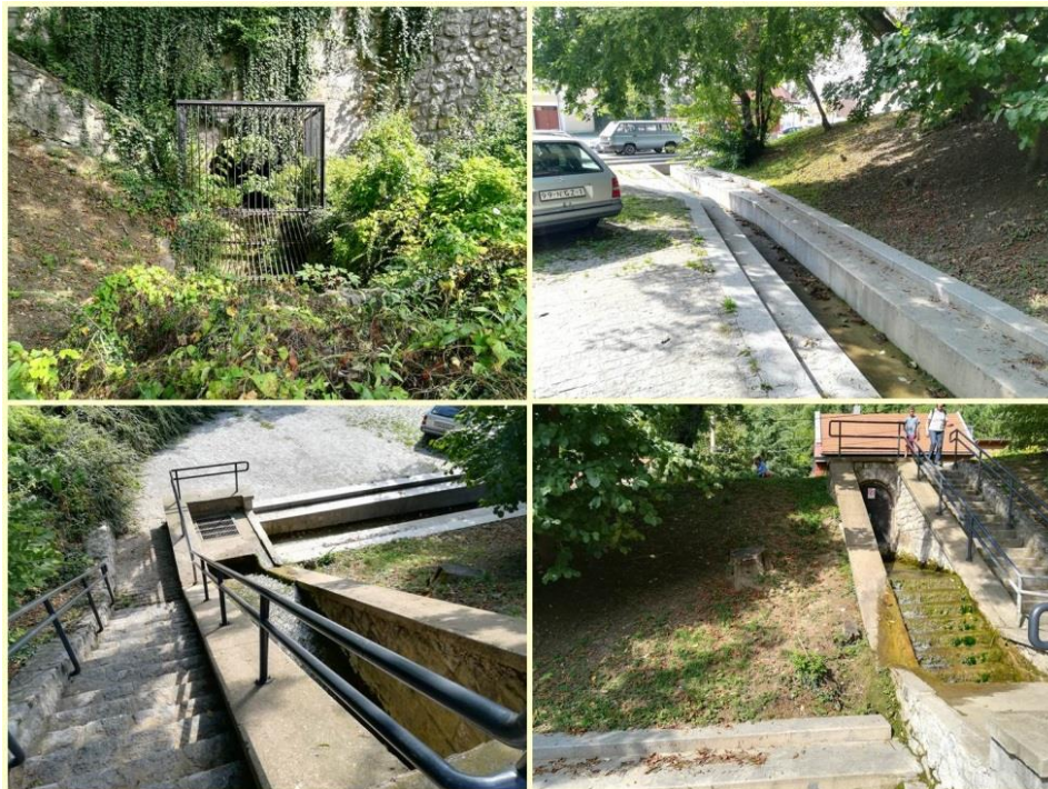
17. kép: A Mecsekről leszárguló esővizek a Tettye forrásnál is okoznak elöntéseket, környékbeli beázásokat. A jelenlegi elvezetőrendszer több interjúalany szerint sem alkalmas az extrém csapadékvolumenek elvezetésére, a klímaváltozáshoz való alkalmazkodás e területen például kulcskérdés.
