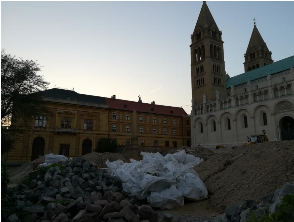
7/b. kép: A szigetelés erősítésére azért van szükség, mert a Mecsek felől a városnak pont erre a részére összpontosulva folynak le a csapadékvizek, melyek mennyisége a szélsőséges esőzések volumen- és gyakoriságnövekménye miatt komoly károkat okoznak.
