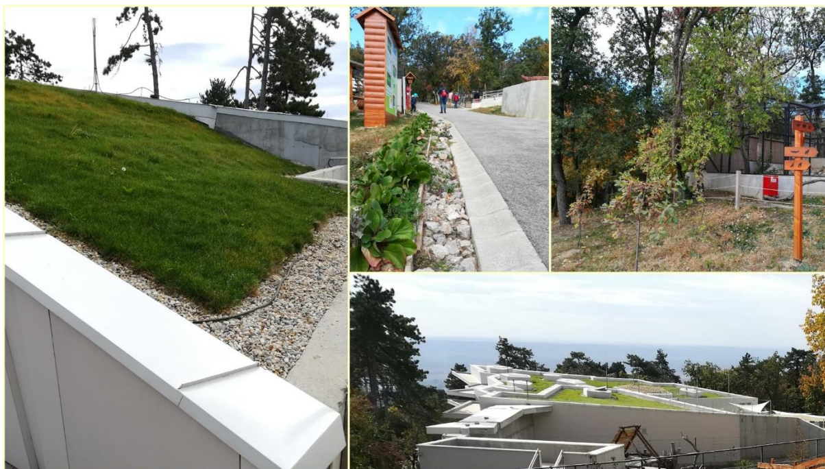
24. kép: A felújítás során – az állatkert hegyoldali fekvéséből is adódóan – természetalapú vízbeszivárogtatási rendszerek kialakítására is sor került (kavicsos drének, zöldtetők, illetve az állatházak és kifutók között megtalálható fás-cserjés területek), melyek egyaránt elősegítik a csapadékvíz hatékonyabb elnyelődését és hasznosulását.
